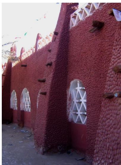
Figure 14: Procédé d'enduits extérieurs à Timimoune (© Foufa Ibtihal Hamza, 2014)
