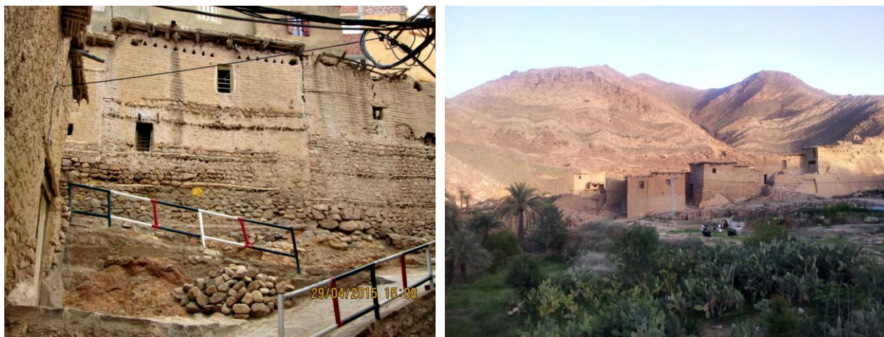
Figure 1: Architecture de terre et de pierres à Menaâ-Aurès (gauche) et à Amenthane-Aurès (droite), Algérie, (©Adjali Samia, 2015)
