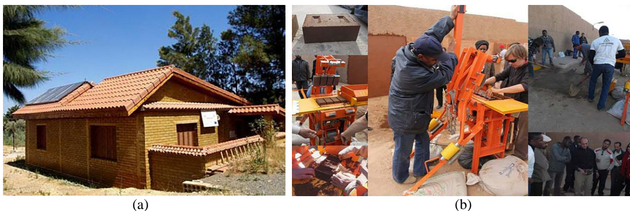
Figure 5: Prototype d'une maison solaire réalisée par le CNERIB (a) (©www.cnerib.edu.dz, Le 14-05-2015); Atelier de formation sur les techniques de fabrication de BTC à Tamanrasset (b)(©prescriptor.info/.../cap-terre-des-ateliers-de-formation-sur-les-techniques, Le 14-05-2015)
