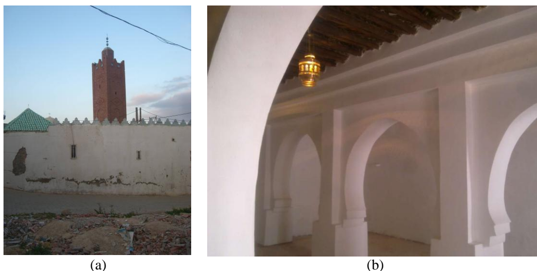
Figure 9: Restauration de la mosquée Zahra à Béni-Snouss, Tlemcen. Avant (a) et après (b)(© Abdessemed-Foufa Amina, 2010)
